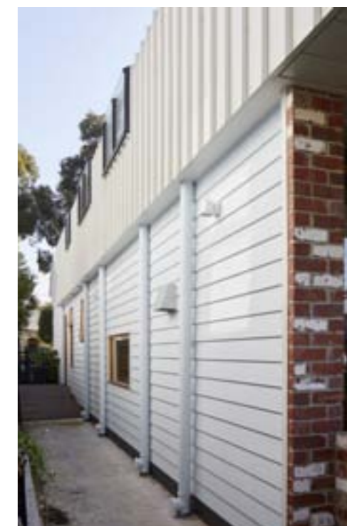
Dům vyplňuje téměř celou šířku pozemku, po obou stranách zůstává jen úzký průchod z předzahrádky dozadu do zahrady. Svislé potrubí odvádí dešťovou vodu ze střechy do podzemních zásobníků
